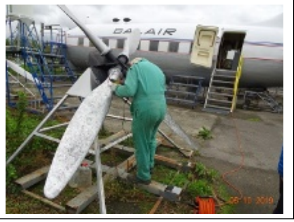
Instandstellen der Propellerblätter
